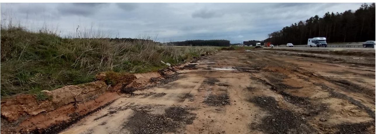
Abbildung 5: Abgeschobener Boden im Vorhabensgebiet; (Foto: R. Fischer)
