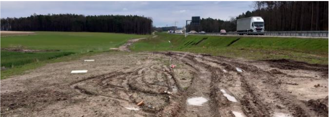
Abbildung 4: Böschung entlang der Autobahn; (Foto: R. Fischer)
